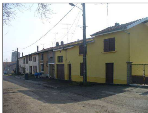
Alignements bâti, rue de Villers.
